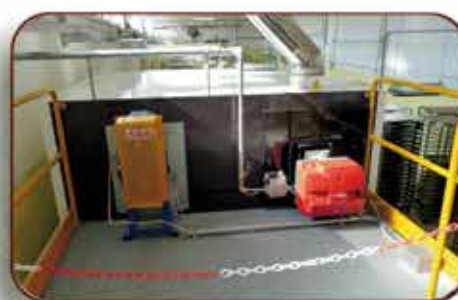
3 Zona fornello: bruciatore e ventilatore fumi. Burner area: burner and flue gas ventilator fan.
